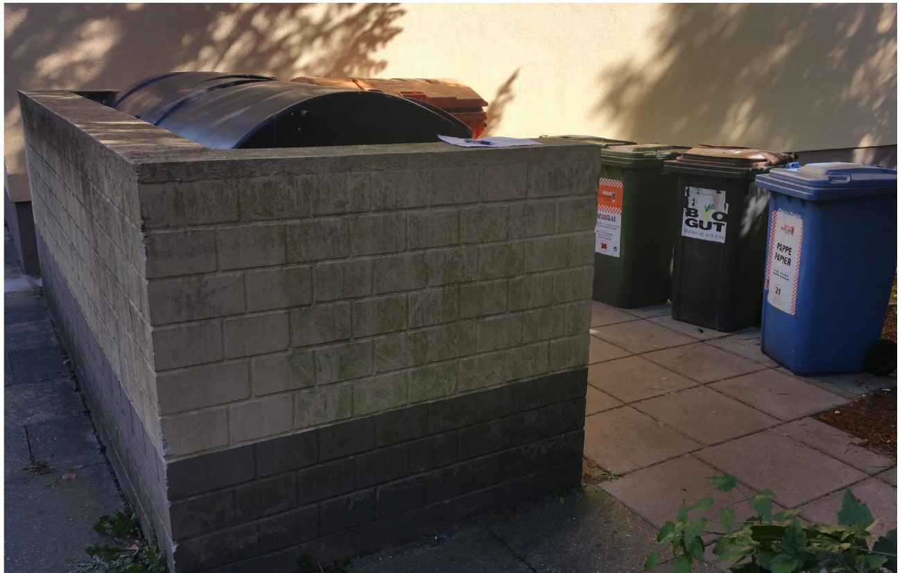
Vor der Baumaßnahme
